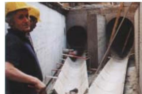
verbessert sich die Dichte des Kanals. Die Wartung wird durch die geringere Oberflächenrauheit bei der neuen Kanalbauweise vereinfacht, die Arbeitsbedingungen haben sich sowohl bei der Herstellung als auch bei der Wartung verbessert, da nicht mehr händisch und nachträglich verfügt werden muss. Zusätzlich wird die Bevölkerung durch Informationskampagnen eingebunden.
